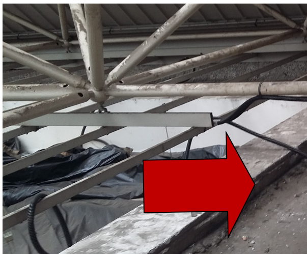
Figura 11 - Struttura metallica esistente utilizzata per ancorare la carpenteria a cui sarà fissato il soffitto teso
