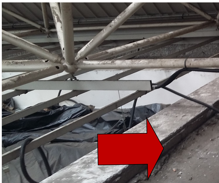
Figura 12 - Carpenteria metallica oggetto di modifica e cerchiatura
